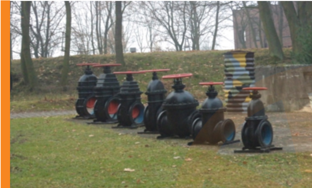
ZESTAW ZABYTKOWYCH ZAWORÓW NA TERENIE ZABYTKOWEJ WODOCIĄGOWNI ZAWADA
